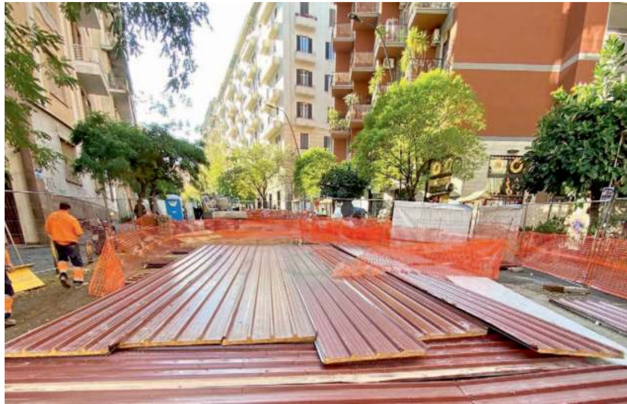
▲ Viale Michelangelo Il maxi-cantiere sigillato con lamiere rosse per evitare che si allaghi con la pioggia
