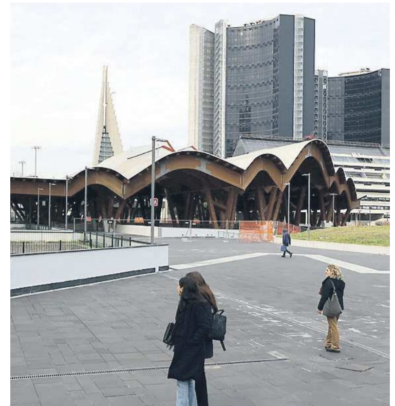
LO SPRINT Il piazzale del metrò liberato dal cantiere NEAPHOTO
