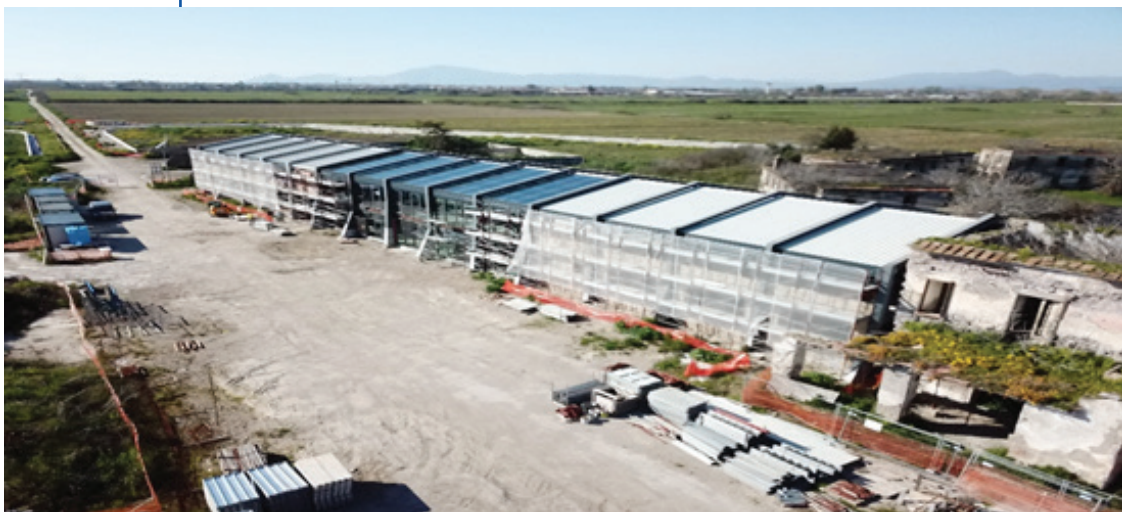
Cantiere dei lavori
