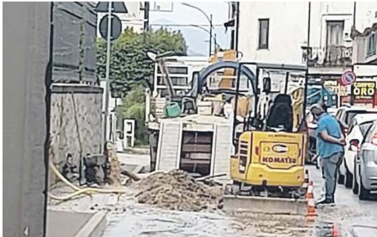
LA VORAGINE La falla in via Caudina e, a destra, i lavori di sostituzione delle condotte idriche con materiale in ghisa
