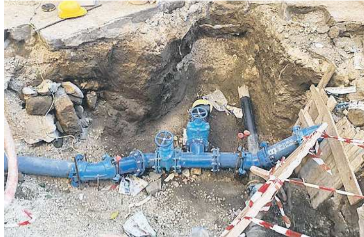
LA VORAGINE La falla in via Caudina e, a destra, i lavori di sostituzione delle condotte idriche con materiale in ghisa
