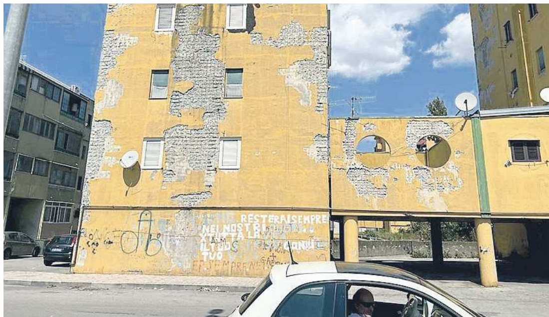
Afragola, il degrado delle facciate al rione Salicelle costruito dopo il sisma del 1980
